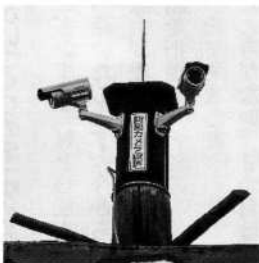
設置した防犯カメラ
